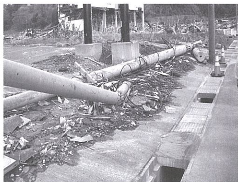
ぽっきり折れた電信柱。見渡す限り立っている電信柱はない。
